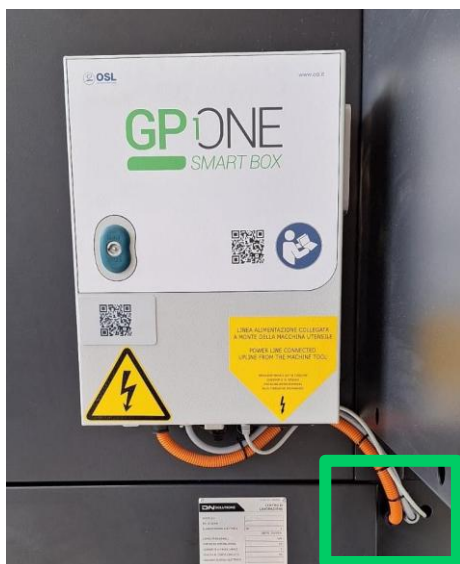
Figura 1 Inserimento cavi in macchina
